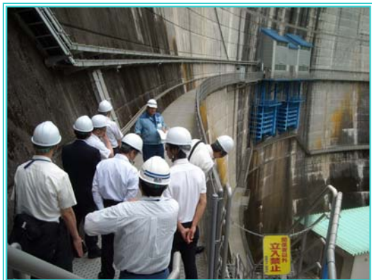
【青蓮寺ダムキャットウォークからの見学】
